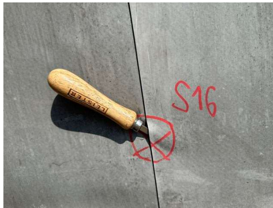
Foto 4: Pohled na jednu z nalezených netěsností (netěsnost S16) – nedostatečně svažený spoj
