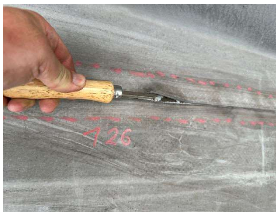
Foto 6: Pohled na největší nalezenou netěsnost (netěsnost 126) – nedostatečně svažený spoj po celé délce šikminy střechy
