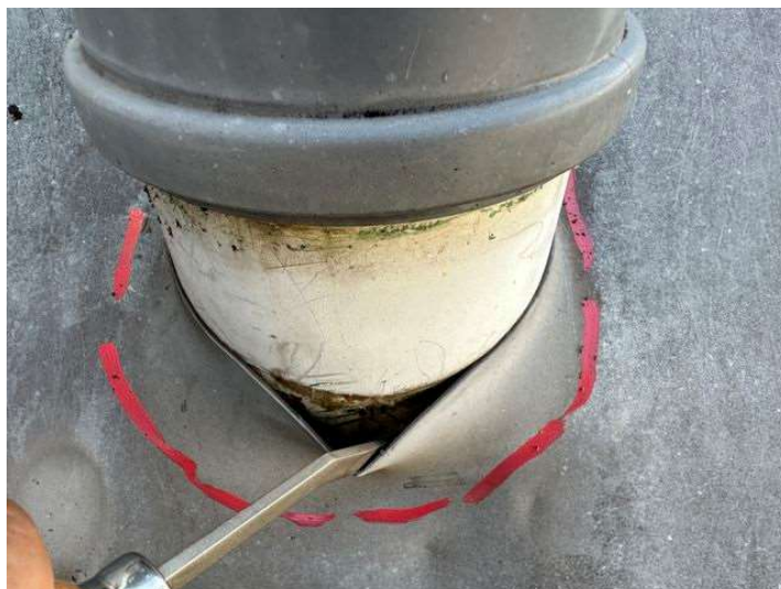
Foto 2: Pohled na netěsné opracování kruhového prostupu povlakovou hydroizolací, absence vytažení povlakové hydroizolace
