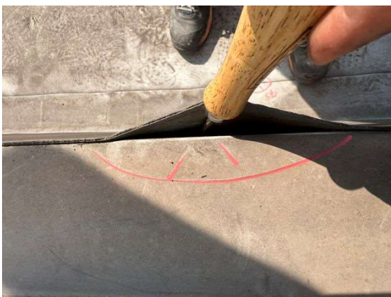
Foto 5: Pohled na nesvaženou část spoje fólie v místě vytažení svislé části povlakové hydroizolace
