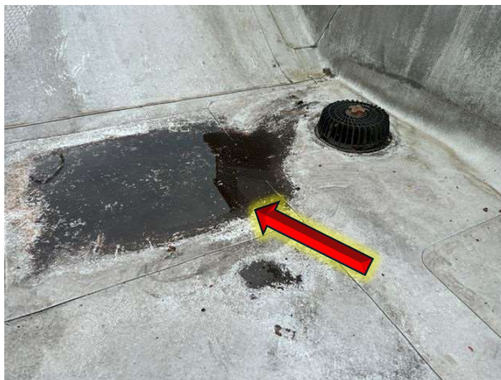
Foto 7: Pohled na jednu z louží na povrchu střešního pláště v těsné blízkosti střešního vtoku, střešní vtok je osazen výše a neumožňuje tak odtok veškeré vody ze střešního pláště
