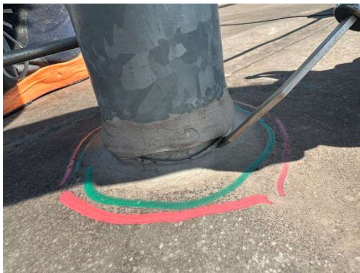
Foto 1: Pohled na netěsnost v opravování prostupu kotevního bodu záchytného systému, absence vytažení povlakové hydroizolace
